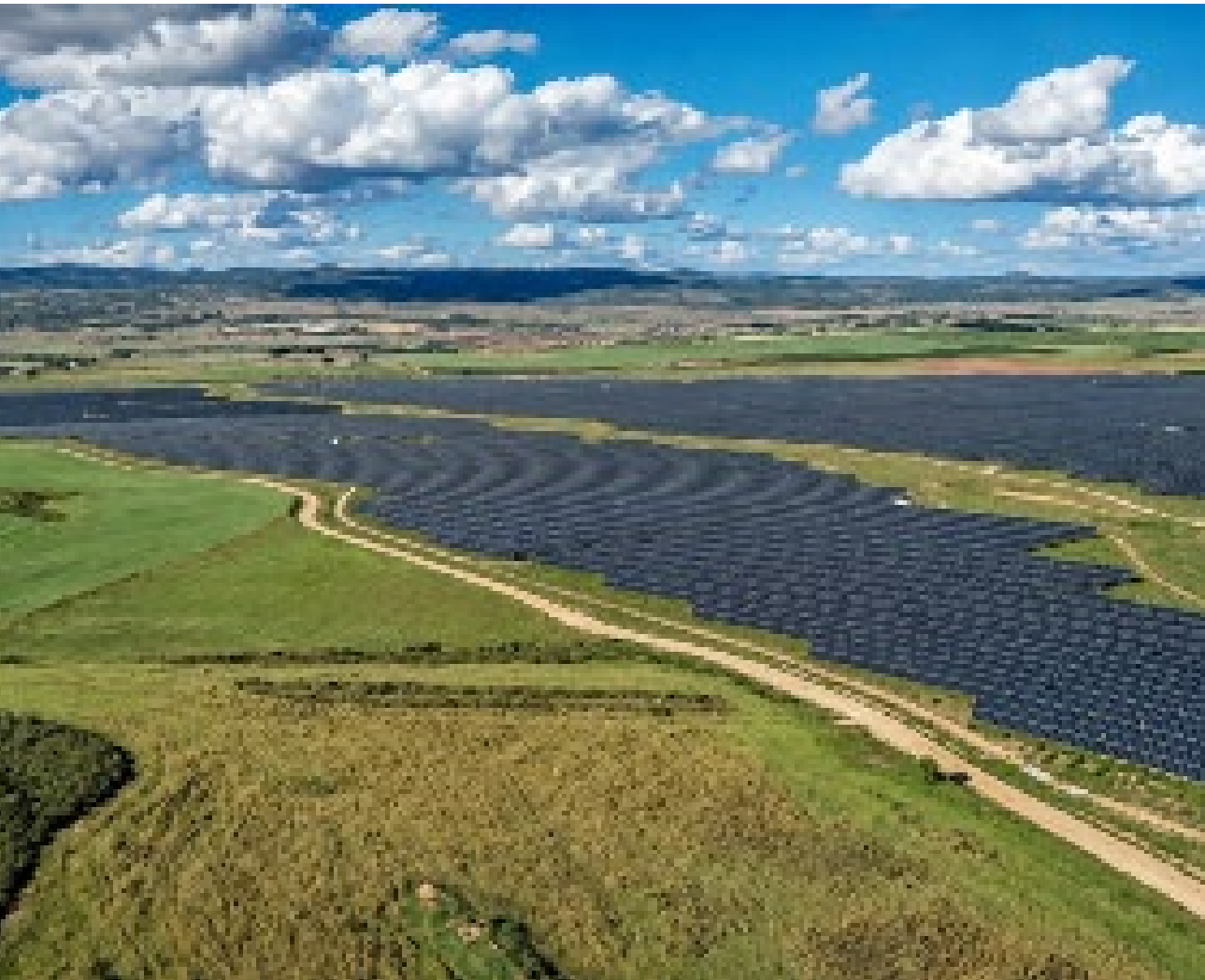
Imagen aérea de la macrocentral solar-fotovoltaica de Casa Alcoy | ANAV.
